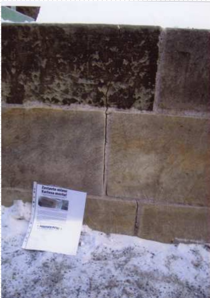
Trhlina po mrazech z ledna 2010 -pole V, sever, východně od sousoší Cyrila a Metoděje. Foto 27.1.2010
