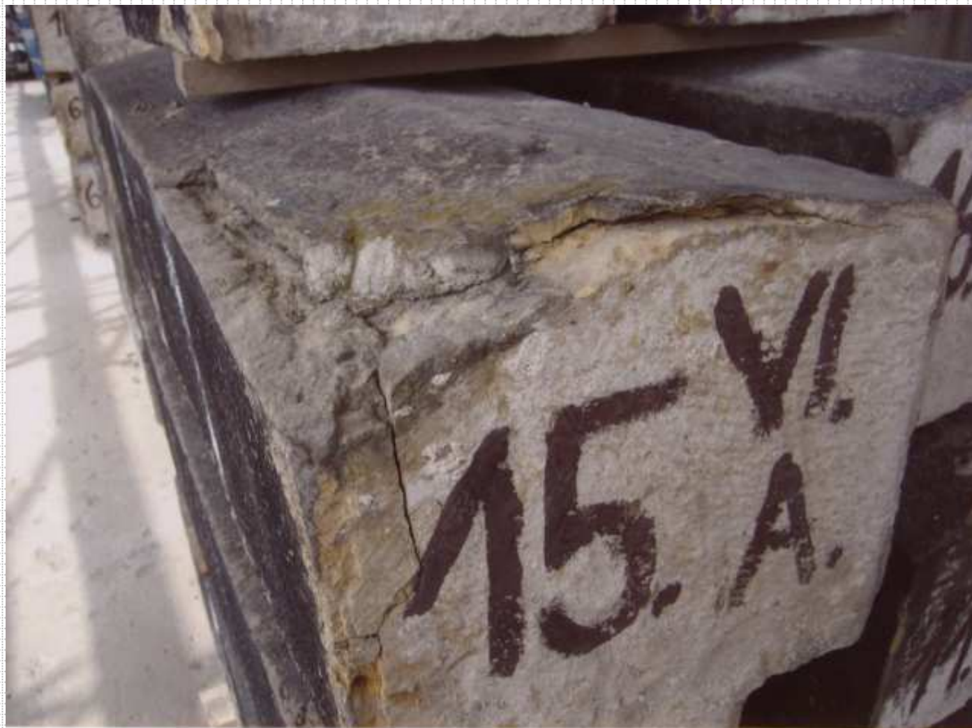
Klenba VI jih – typ povrchového a bočního zvětrávání-praskliny (Hořický pískovec). Foto 15.9.2009
