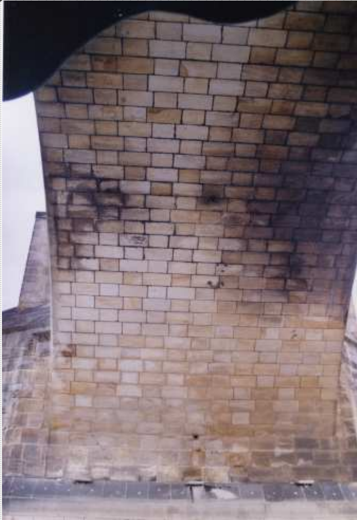
Klenba V při pilíři 5, západní část západní část
