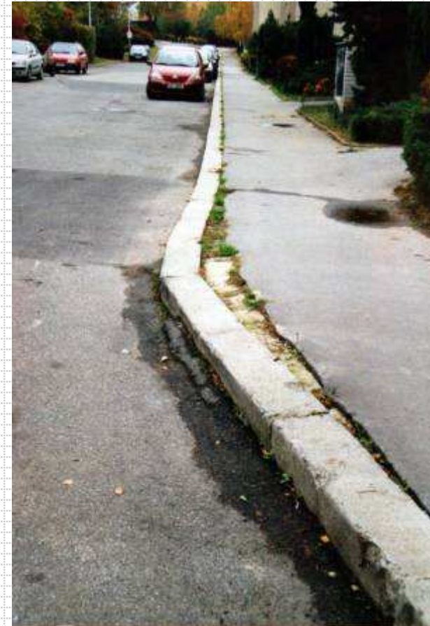
Vybočení kamenných důsledku teplotních
