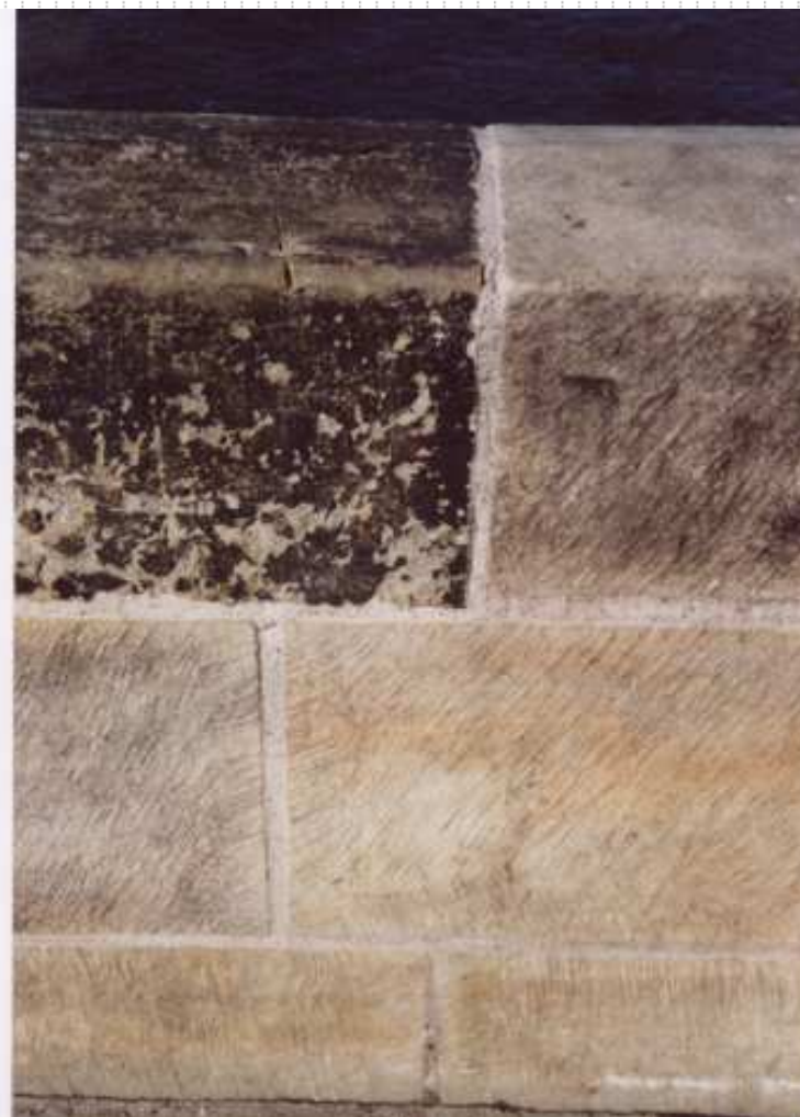
Stejné místo - po oteplení a osvětlení sluncem se trhlina uzavřela. Foto 22.3.2010
