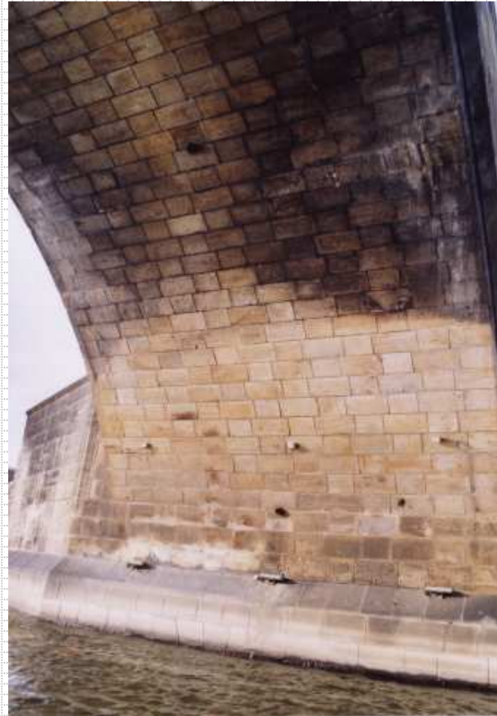
Klenba VI při pilíři 6, západní část
