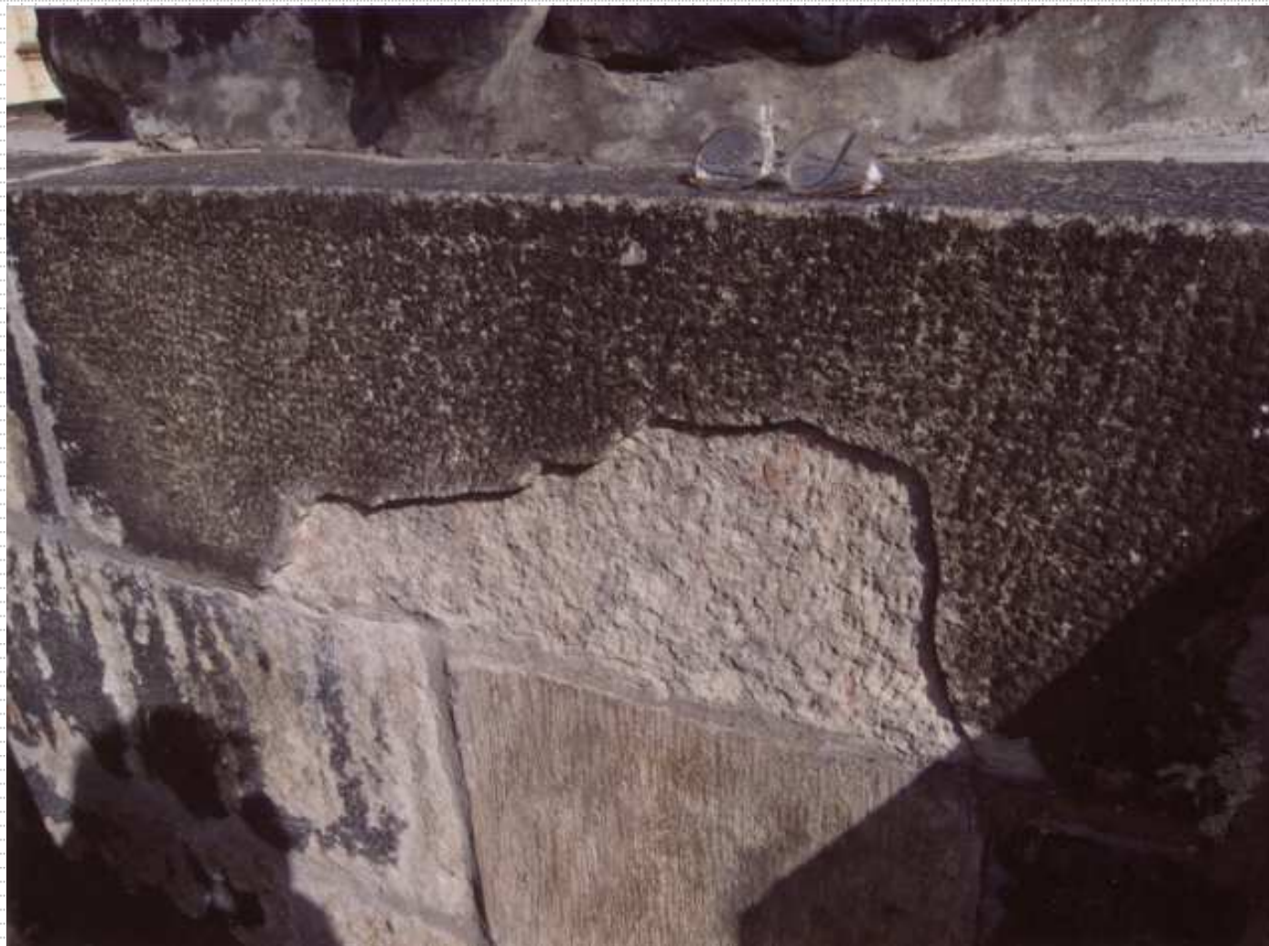
„Čerstvě“ poškozený „opravený“ kamenný kvádr v sousoší na pilíři č.14 sever. Socha sv. Víta. Foto 4.4.2010
